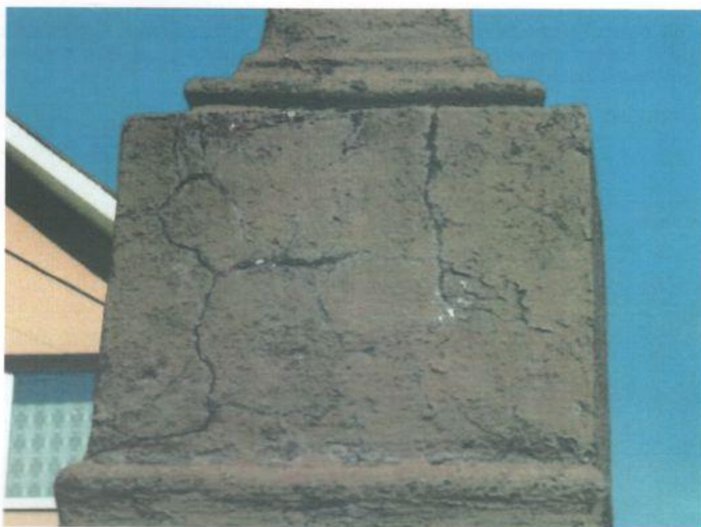
Fot. 6. Obec Vitánová, okres Tvrdošín, v Žilinskom kraji, na severe Slovenska. Kamenný kríž s vyobrazením Krista a Sedembolestnej Panny Márie. Pohľad na stĺp a hlavicu s odlupujúcou sa olejovou vrstvou náteru. Fot. M. Książek 2019
